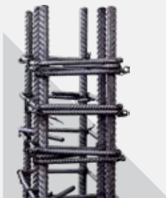
Columnas y vigas
