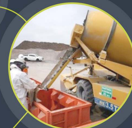
Compactaje del material
