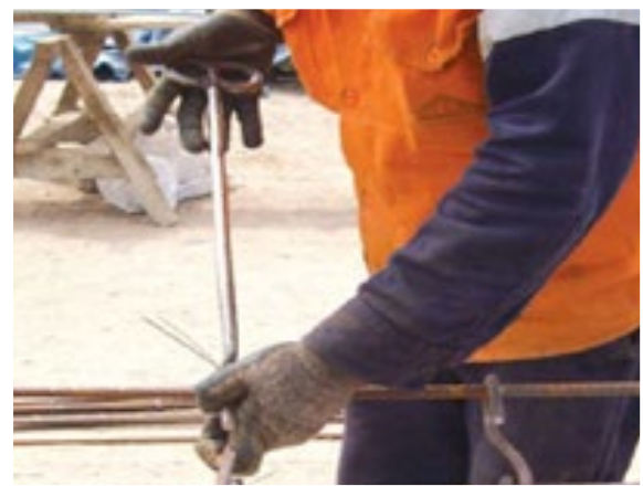
Figura 2. Procesos de habilitado y armado de acero de refuerzo.
