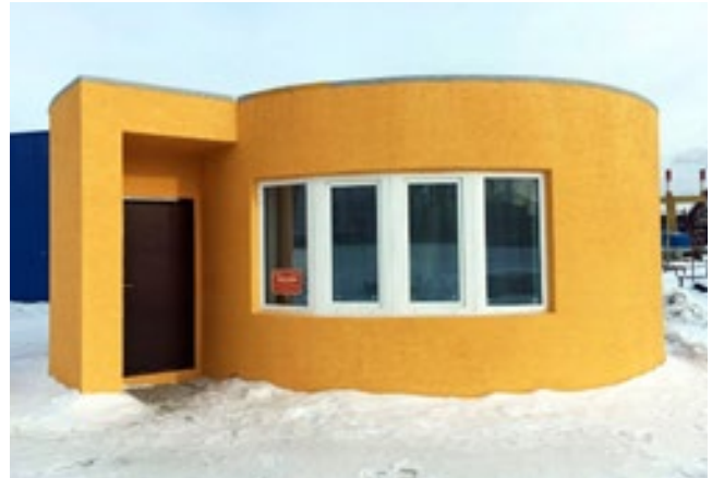
Figura 9. Impresión 3D en sitio de Apis Cor ( http://apis-cor.com/ consultado el 12 de septiembre de 2018).
