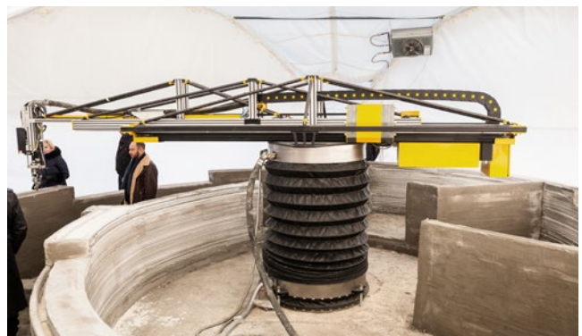
Figura 7. Impresora tipo brazo rotatorio ( http://apis-cor.com/ consultado el 15/08/2018).
