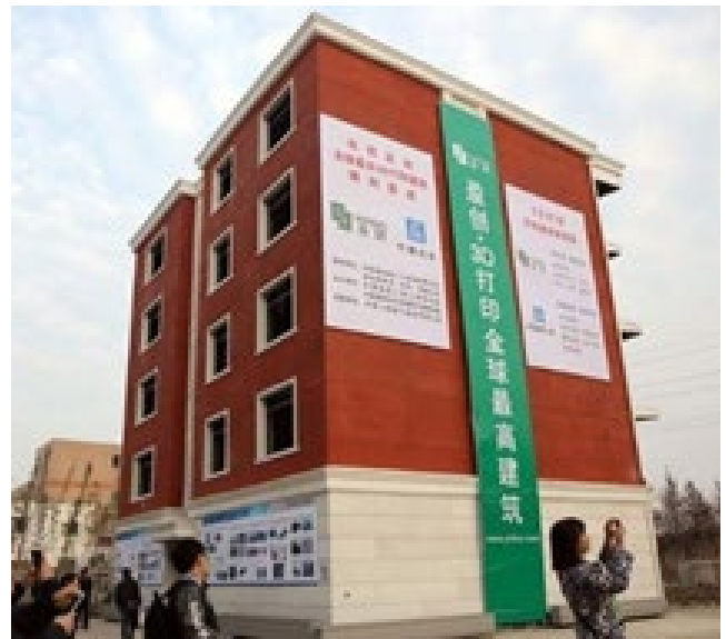
Figura 8. Edificio con elementos prefabricados por impresora 3D ( www.winsun3d.com/En/ consultado el 02/09/2018).
