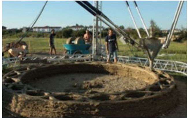
Figura 5. Impresora de cables suspendidos ( www.wasproject.it/w/en/ consultado el 06/09/2018).
