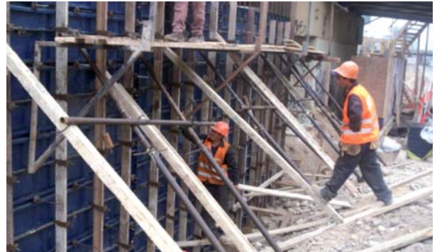
Apuntalamiento del encofrado
