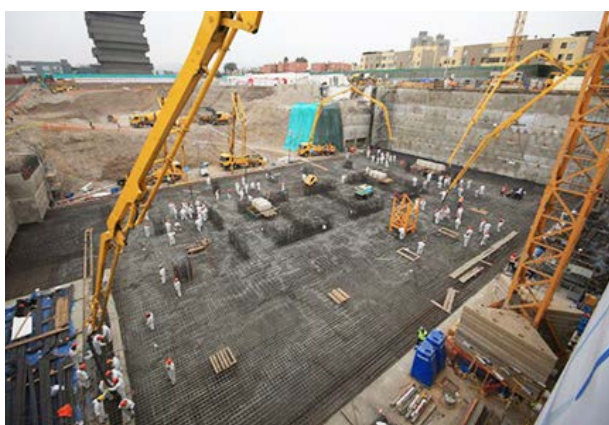
VACIADO MASIVO DE CONCRETO
