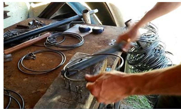
ESTRIBOS CIRCULARES INDIVIDUALES | Foto N° 2
